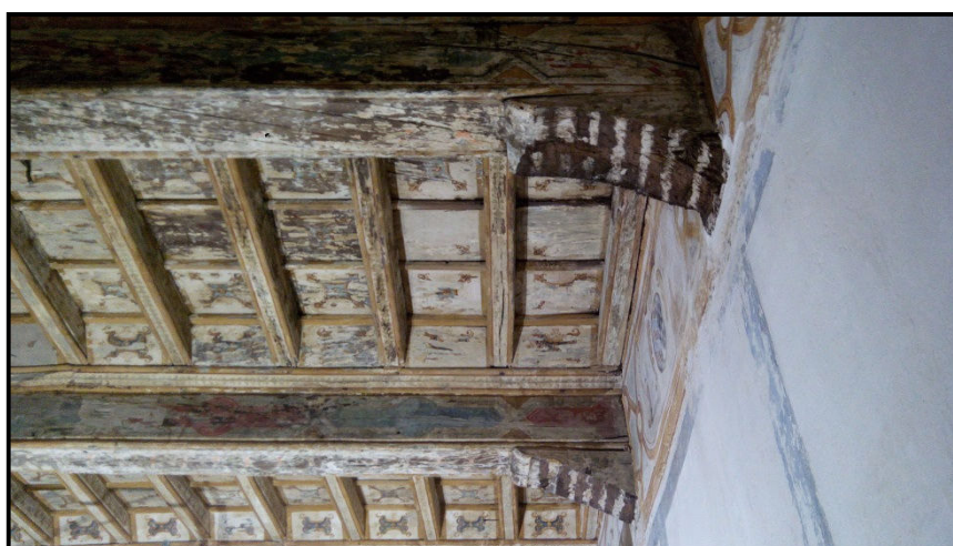
Solaio 3: particolare degli appoggi
